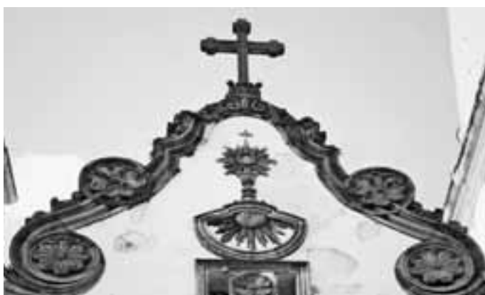
Figura n.º 8 Detalhe do frontão da Igreja Matriz do Santíssimo Sacramento e Sant'Ana
